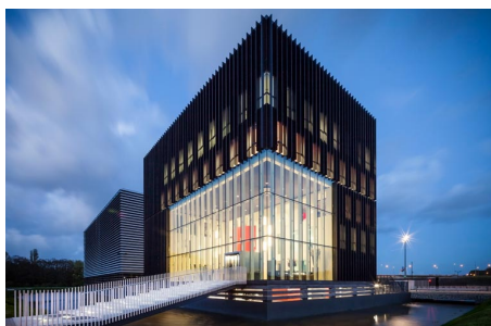
FIG. 8 – Images AM3 Amsterdam, Cold corridor, confinement aérolique, green computing, green IT (optimisation des infrastructures IT, bâtiment, énergie, exploitation)
